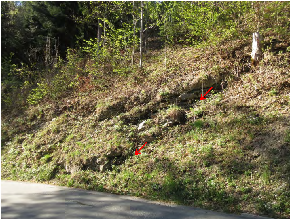
Foto 10: Blick nach Südosten, bergseitige Strassenböschung mit lokaler Vernässung (Pfeile).
