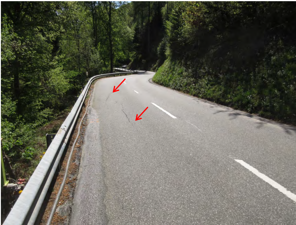
Foto 11: Blick nach Südosten, Strasse mit Rissen in der bergwärts führenden Spur (Pfeile).
