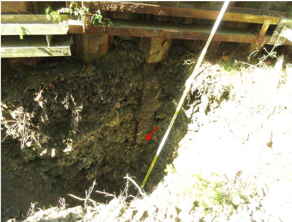
Foto 1: Baggerschlitz BS1 mit UK Spundwand in ca. 2 m ab OKT (Pfeil)
