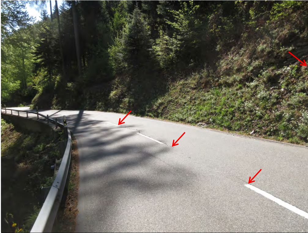
Foto 9: Blick nach Südosten, Strasse mit Rissen in der Fahrbahnmitte (Pfeile).
